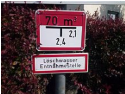
Hinweisschild auf eine Saugstelle in Grävenwiesbach mit einem Volumen von 70m 3
