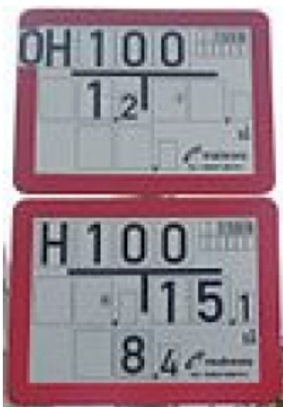
Hinweisschild auf Über- und Unterflurhydrantenschild in Frankfurt am Main
