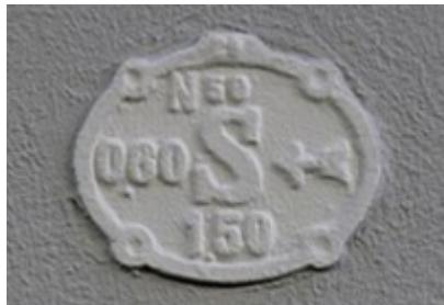
Hinweisschilder zu Straßeneinbauten weisen auf (Straßenkappen von) Straßeneinbauten wie Unterflurhydranten oder Absperrschieber von Wasserversorgungs-, Abwasserentsorgungs-, Gas-, Fernwärme- und Energieversorgungsunternehmen hin.
