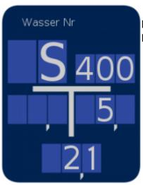
Hinweisschild für den Schieber einer Leitung mit 40 Zentimeter Innendurchmesser (DN 400) bietet, der sich 5 Meter rechts und 2,1 Meter vor diesem Schild befindet.
