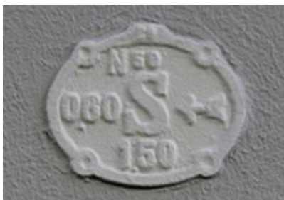
Historisches Hinweisschild (Wasserschieber)
