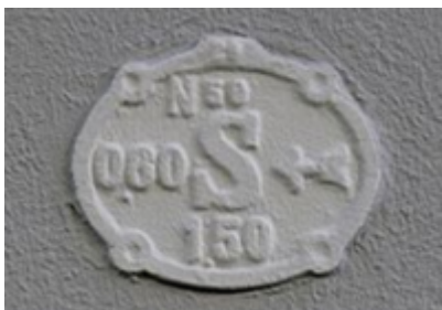
Historisches Hinweisschild (Wasserschieber)
