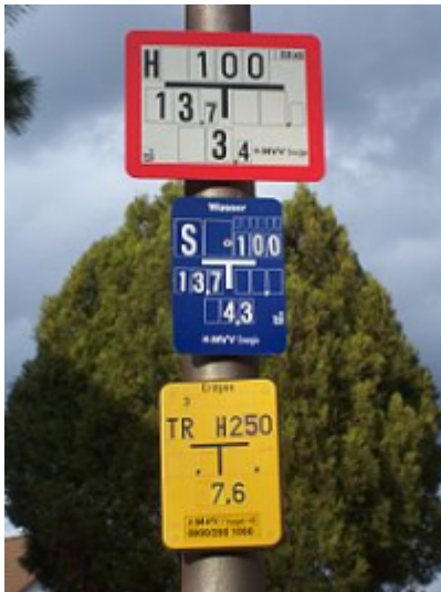
Hinweisschilder für Hydrant, Wasserschieber und Erdgas
